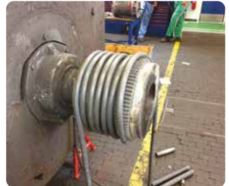
Erwärmung einer Kupplung zur Demontage
